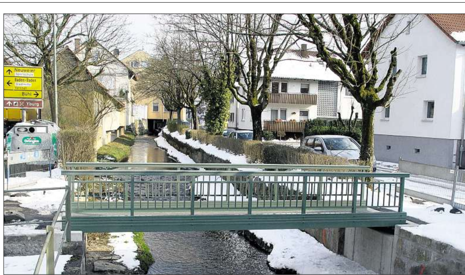
DIE NEUE BRÜCKE ÜBER DEN STEINBACH wurde dieser Tage montiert. Bis sie für Fußgänger freigegeben wird, dauert es nach Mitteilung der Ortsverwaltung aber noch einige Tage. Foto: Fischer
