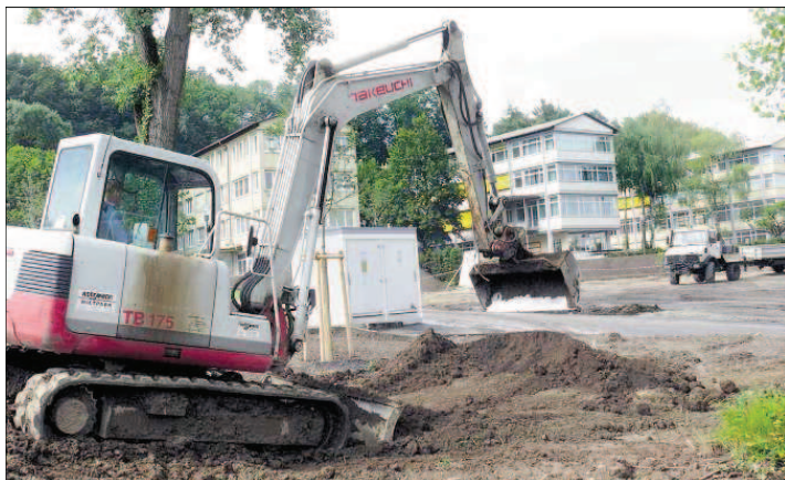
VIELE TONNEN ERDREICH haben Bagger und Arbeiter bewegt, um den Euraka-Campus in der Baden-Badener Cité zu gestalten. Foto: Krause
